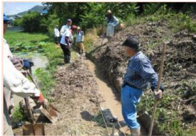
大雨後の応急措置 亀水環境保全委員会 (高松市)
