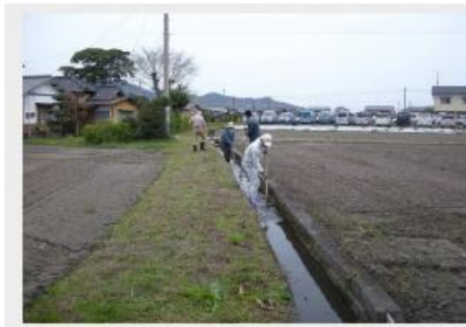
水路の泥上げ
