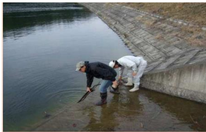
ため池の流入口に溜まっていた流木やゴミ等の除去作業を実施 福田原環境保全会（観音寺市）
