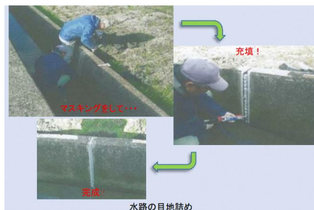
水路の目地詰め
