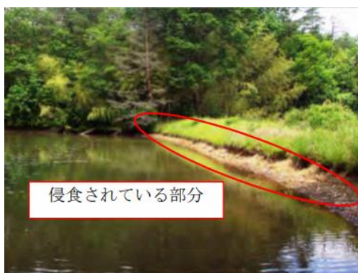
侵食が生じているため池堤体
