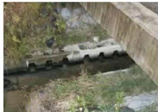
多孔コンクリート護岸
