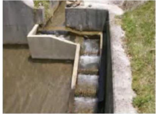
段差解消水路
