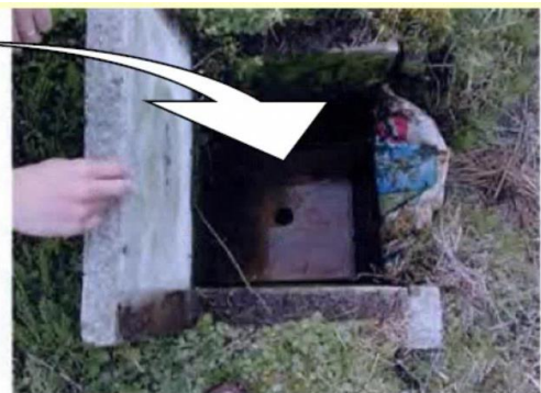
排水調整板設置状況
