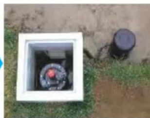
給水栓の自動化へ改良
