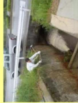
豪雨前にため池の水を抜き、水位調整のためゲート操作を実施
