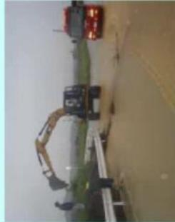
湛水確認後、応急措置として土砂除去を実施
