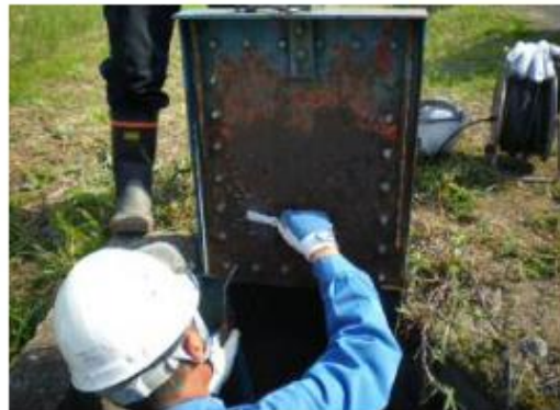
ゲートの補修状況
