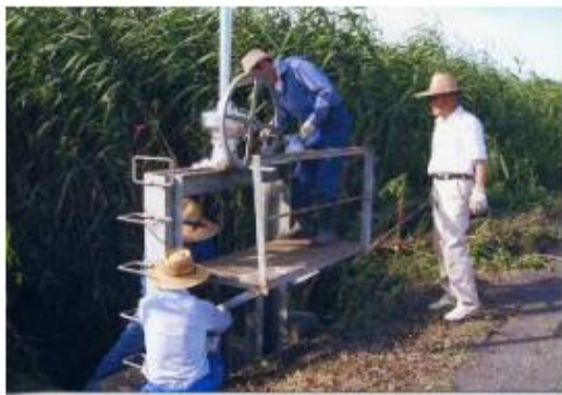
ゲートの点検
