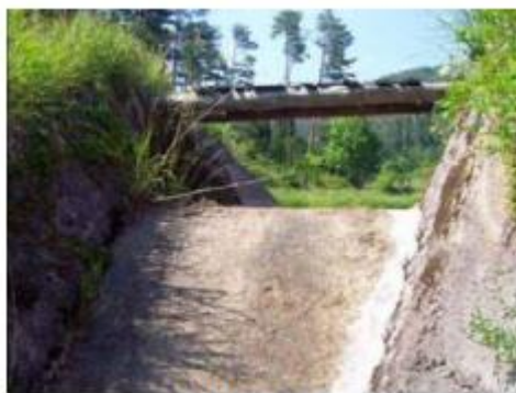
洪水吐の補修
