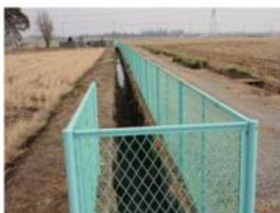
新たに設置された 金網フェンス
