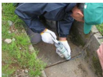
コーキングガンを使用した シーリング材充填
