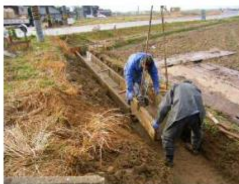
水路の再布設
