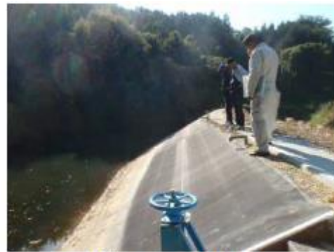
遮水シートの設置
