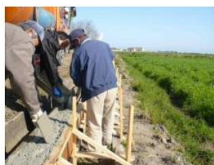
側壁嵩上げ部へのコンクリート打設
