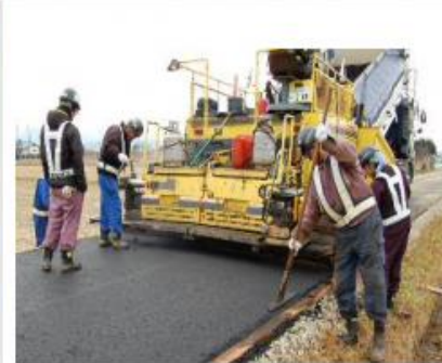
アスファルト舗装状況
