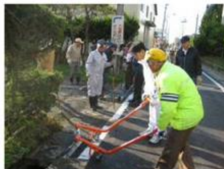
水路蓋の設置 (専用器具使用)
