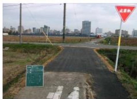
アスファルト舗装の打換え
