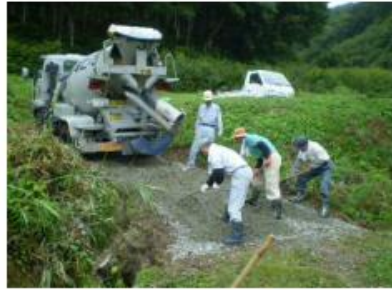
コンクリート舗装状況
